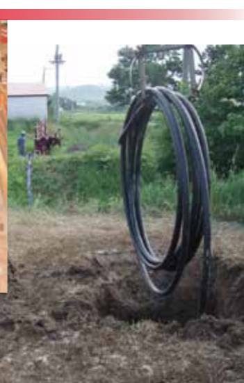
束巻き管施工
